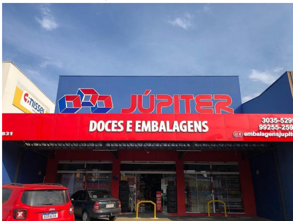
FIGURA 1 — Fachada da empresa
